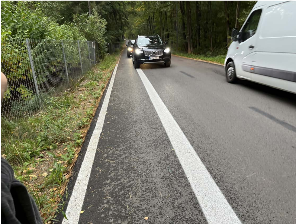
Zdjęcie 18 kierowcy naruszający krawędź jezdni, aby się wyminąć
