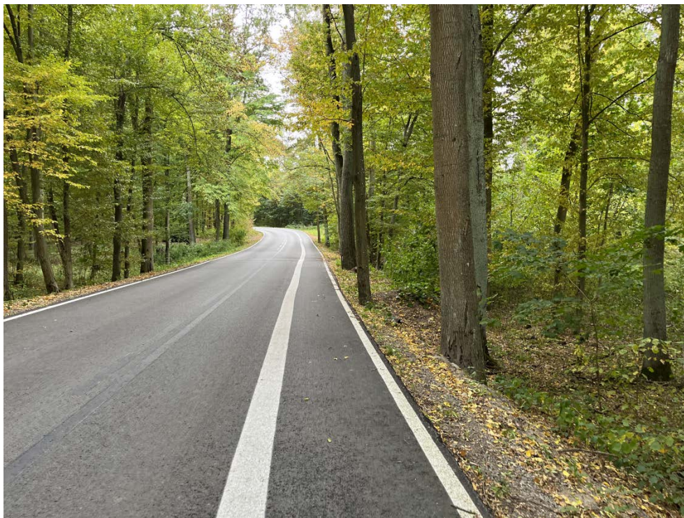
Zdjęcie 2 drzewa blisko krawędzi jezdni (nawet 40 cm)
