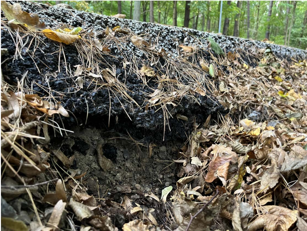
Zdjęcie 6 Uskok nawierzchni
