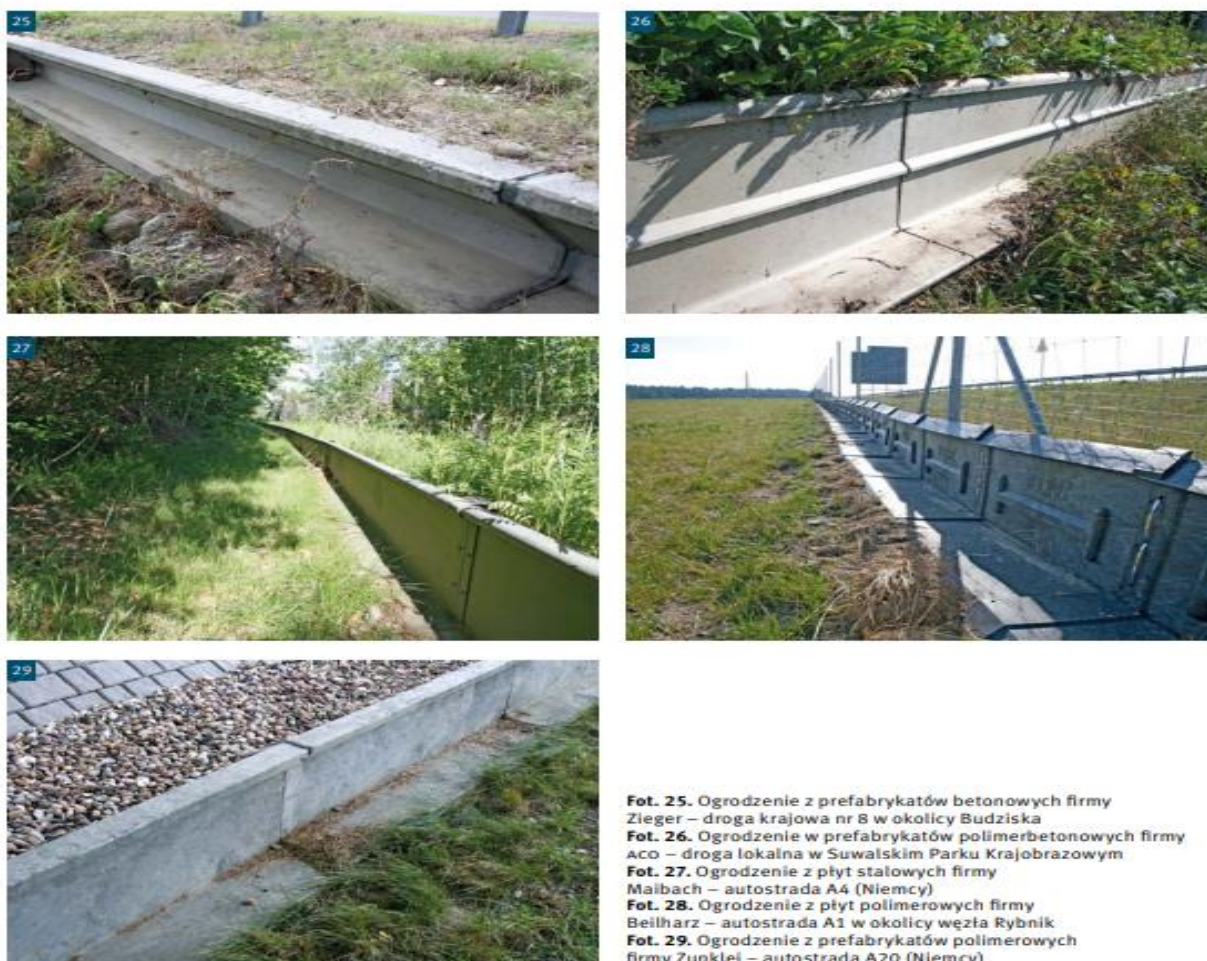
Ryc. 8. Przykłady stałych ogrodzeń naprowadzających (Kurek i wsp. 2011).
